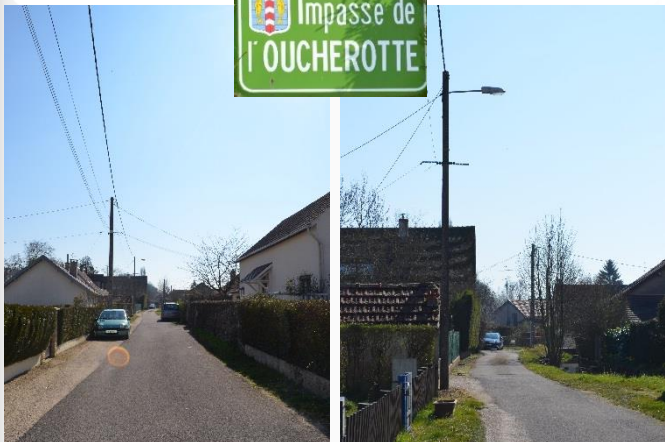
Réfection de la chaussée.
